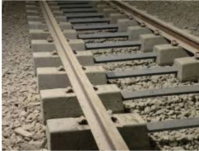
Imagen 14: Ejemplo de durmiente bibloque de concreto
