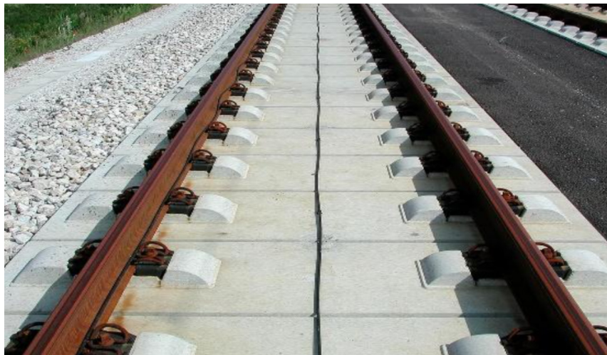
Imagen 15: Ejemplo de semi durmiente de concreto
