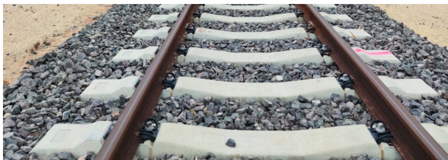
Imagen 13: Ejemplo de durmiente monobloque de concreto
