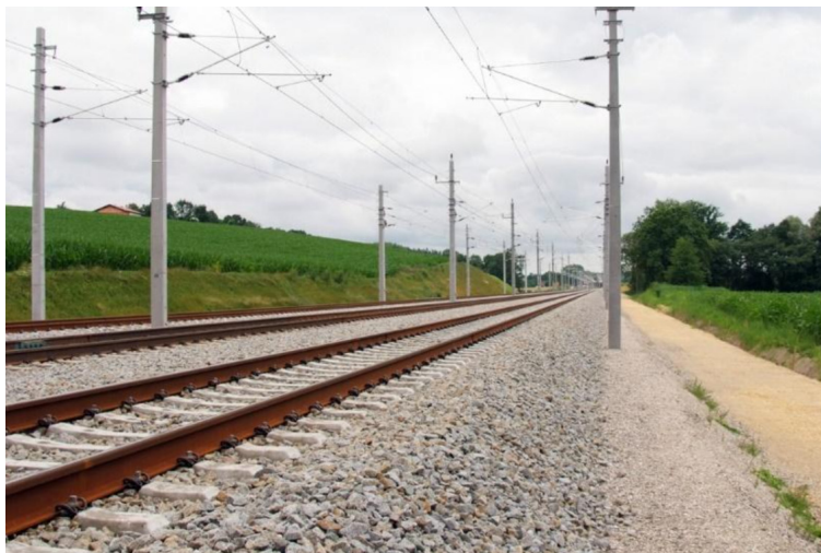
Imagen 10: Ejemplo de Balasto colocada correctamente
