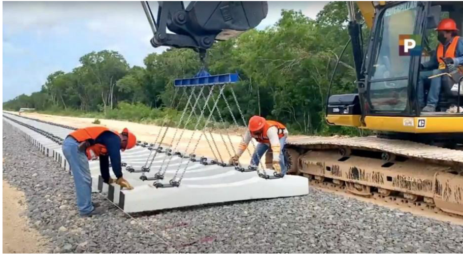
Imagen 6: Colocación de Durmientes Tramo 2-3-4 del Tren Maya
