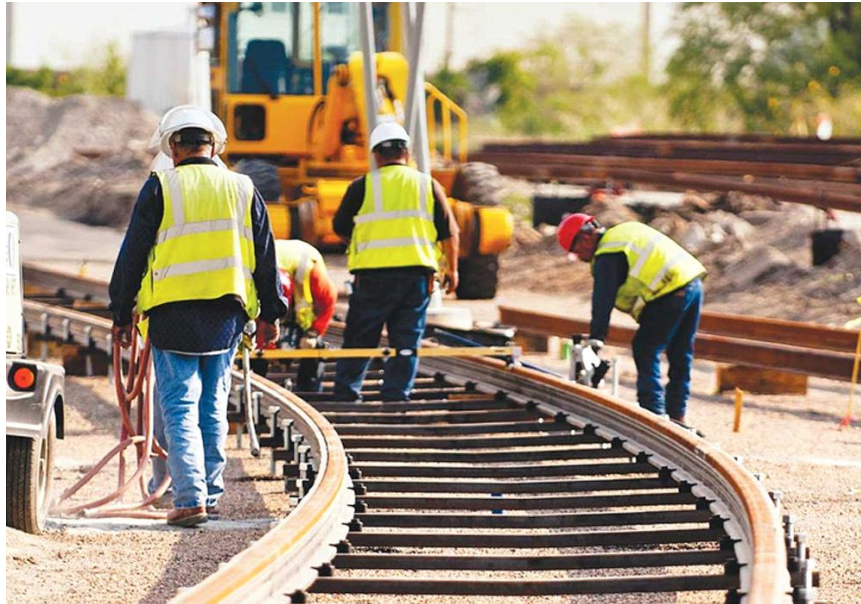
Imagen 22: Ensamblado de vía
