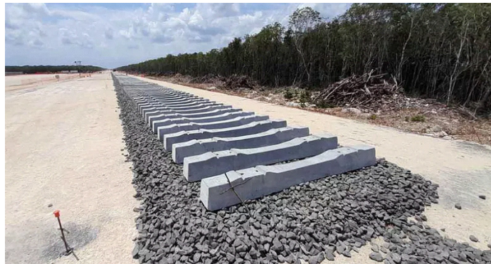
Imagen 20: Colocación de durmientes sobre lecho de balasto
