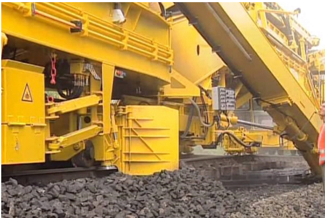
Imagen 23: Riego, bateo y regulado de balasto
