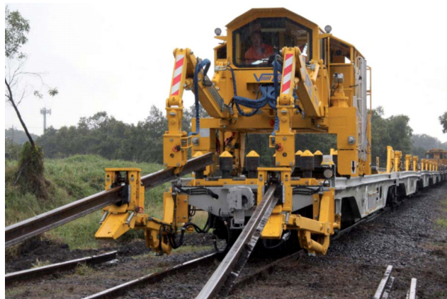
Imagen 21: Tren Carrilero, colocación de riel
